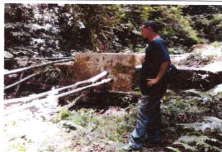
Kondisi Outlet Intake Kali Mukufoka
