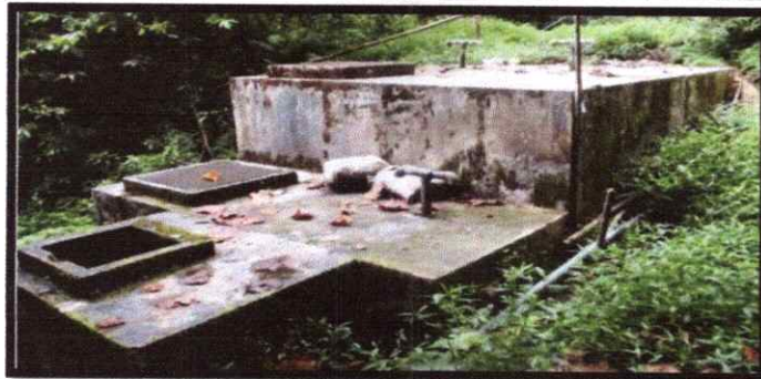
Gambar 3.11. Bangunan Broncaptering Wae Lerong
