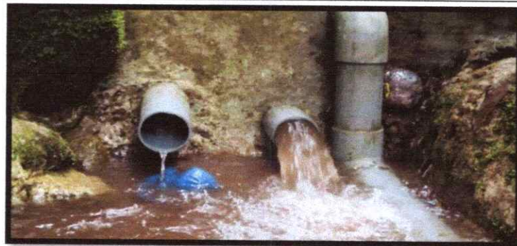
Gambar 3.10. Bangunan Broncaptering Wae Nggernggok
