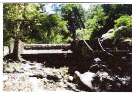
Tampak hilir Bangunan Penangkap
